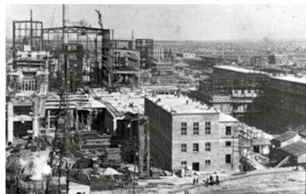
Kraftwerk Baustelle Buna-Monowitz
